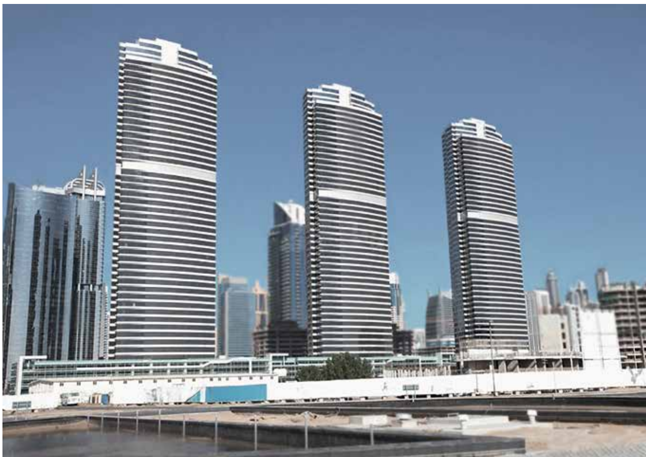
Mazaya Residence w Dubaju System Centralnej Baterii zawierający 1.200 szt. opraw awaryjnego oświetlenie ewakuacyjnego.
