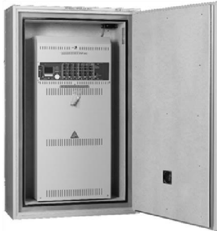
Abbildung 13: miniControl plus im E30-Brandschutzverteilergehäuse
